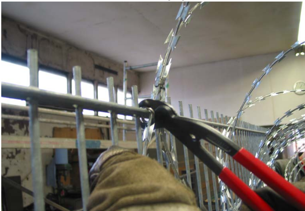
Befestigung Natodraht an Gitterzaun mit Edelstahl C-Klammern, Rollendurchmesser 450 mm
